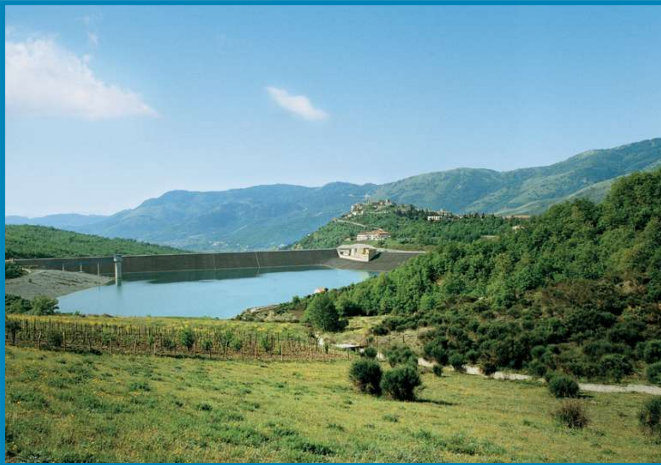
Invaso di Marsico Nuovo sul fiume Agri
